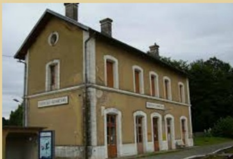
GARE DE POMPADOUR CAPI mis hors service temporairement
